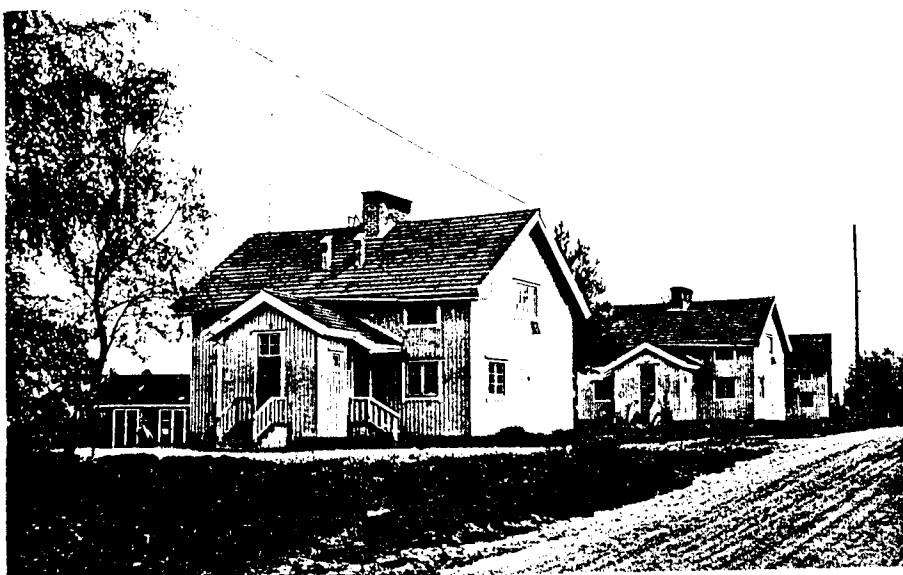
Torikadun (nykyinen Kiisukatu) kaksikerroksiset neljän perheen talot olivat kaivosyhtiön rakennusosaston tuotantoa. Rakentamisessa jouduttiin käyttämään monia korvaavia materiaaleja. Kuva Olavi Leskinen 1964. OKKA.
