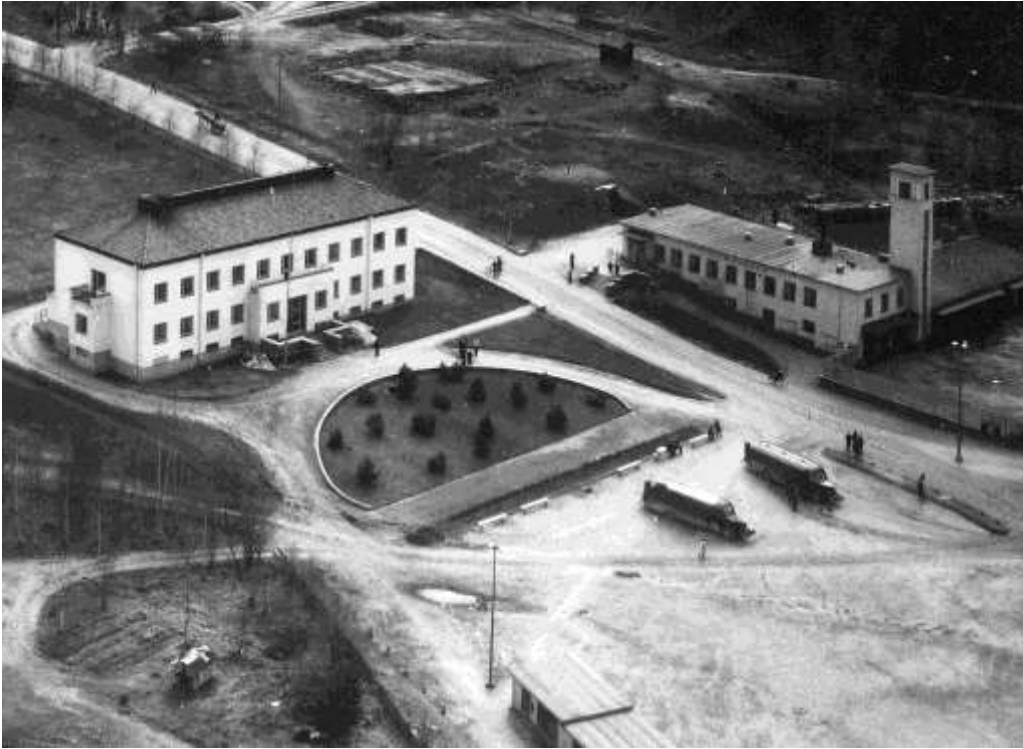
Funktionalitista Alatoria vuodelta 1946. Oikeanpuoleinen rakennus on Palmqvistin suunnittelema kaivoksen paloasema ja vasemmanpuoleinen Ullbergin piirtämä kaivosyhtiön konttorirakennus. Kuva Outokummun kaivosmuseo
