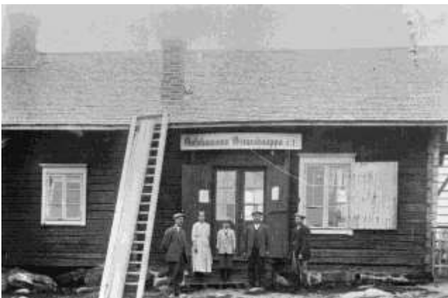
Outokummun Osuuskauppa oli nykyisen Kummunkadun varren ensimmäisiä, ellei ensimmäinen, liikerakennus. Kuva Outokummun kaivosmuseo
