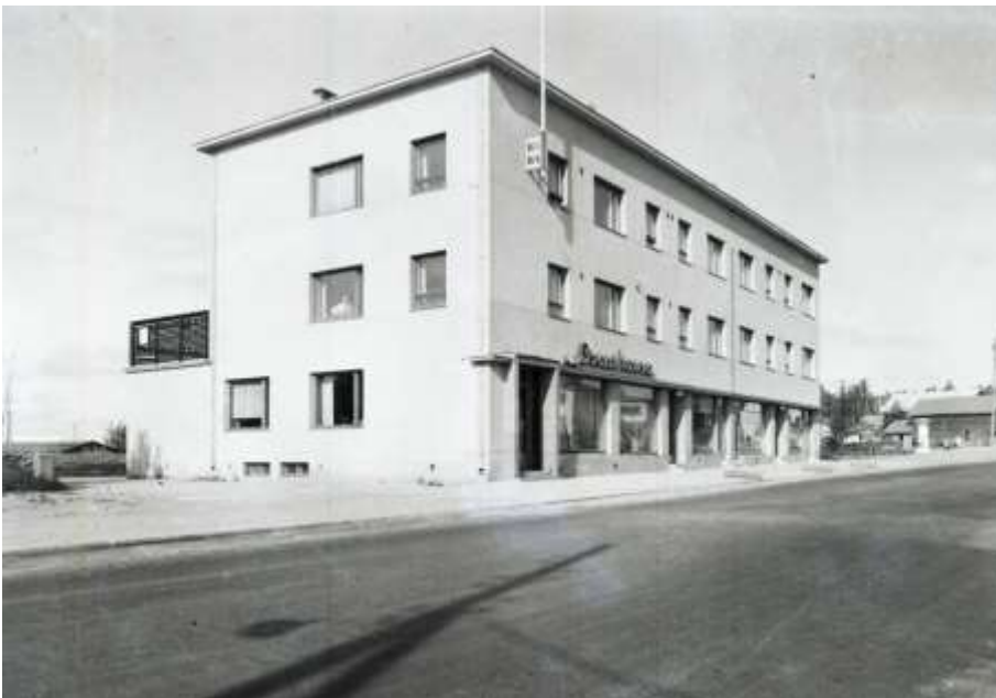
Kuusjärven Osuuskassan rakennus toi omalla panoksellaan Outokummun liikekeskustan kaupunkikuvaan kivirakentamisen jyrkyyttä. Kuva Outokummun kaivosmuseo
