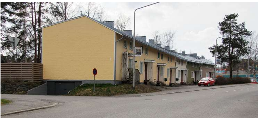
Liikekeskustan kupeeseen vuonna 1956 valmistunut Arkkitehtitoimisto Blomstedt & Lampénin suunnittelema rivitalo (nk. Käärmetalo) on Pohjois-Karjalan ensimmäinen moderni rivitalo. Kuva Pekka Piiparinen (2013)
