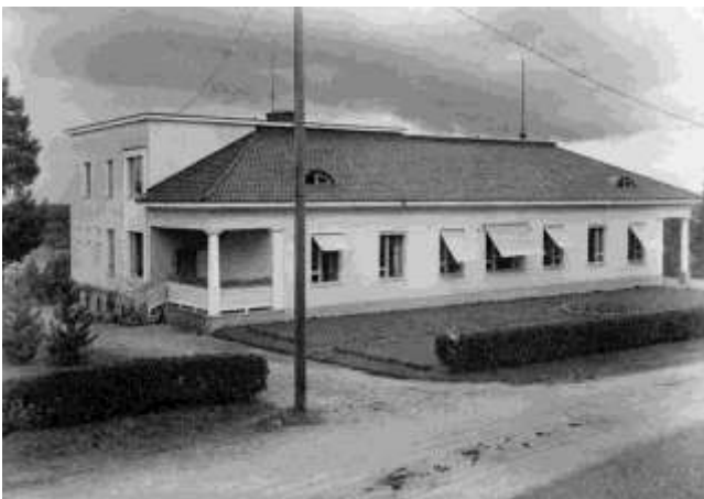
Kaivoksen sairaalarakennuksessa näkyvät funktionalismin ja klassismin tyylipiirteet. Sairaalan Palmqvist suunnitteli 1930-luvun jälkipuoliskolla. Kuva Outokummun kaivosmuseo
