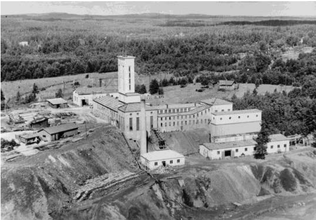
Mökkivaaran kuilu ja siihen liittyneet teollisuuslaitokset valmistuivat vuonna 1939.
