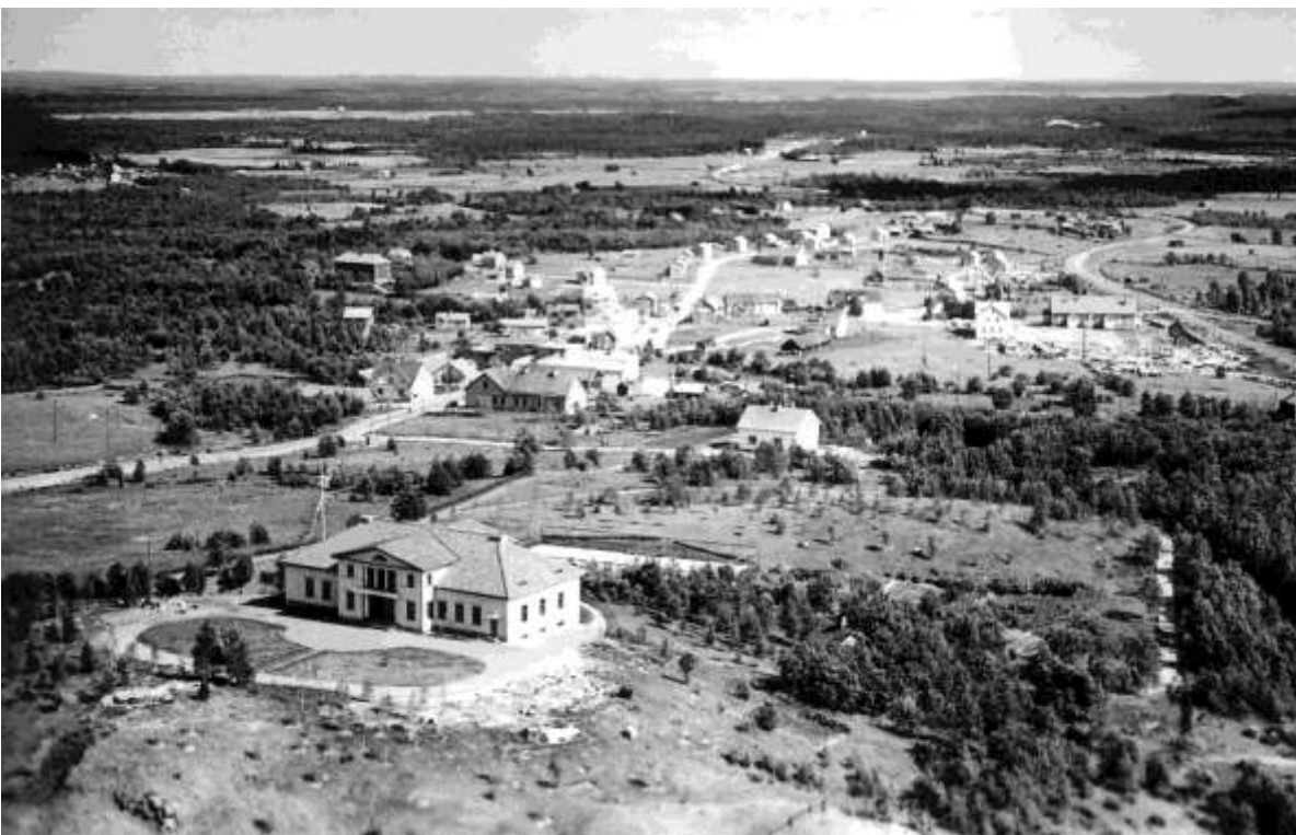
Kivinen Sänkivaara rakennettiin kaivoksen ja liikekeskustan välille mäen päälle vuonna 1939. Rakennuksen sijainti Outokummun kaupunkikuvassa oli pitkään merkittävä ennen sen ympärillä olevien koivujen kasvamista, joka peitti kohteen näkyvyyden. Kuva Outokummun kaivosmuseo
